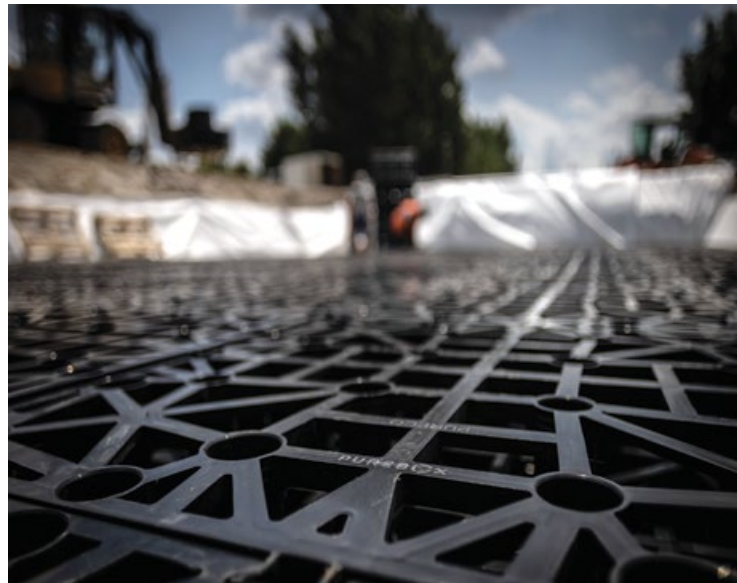
Csapadékvíz szikkasztó telepítés
