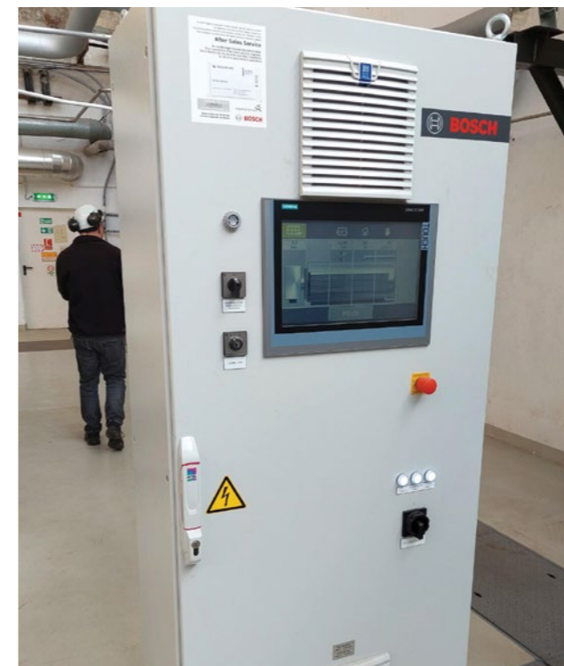
A Bosch ELSB villanykazán a tesztek után és a vezérlőpanel
