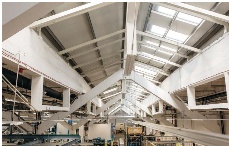
» A Knorr-Bremse szervizközpontja teljes felújításon esett át
