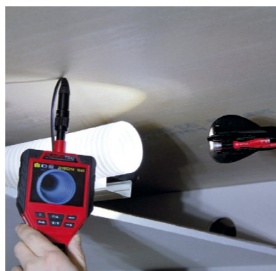
» Légtechnika-vizsgálat és karbantartás
