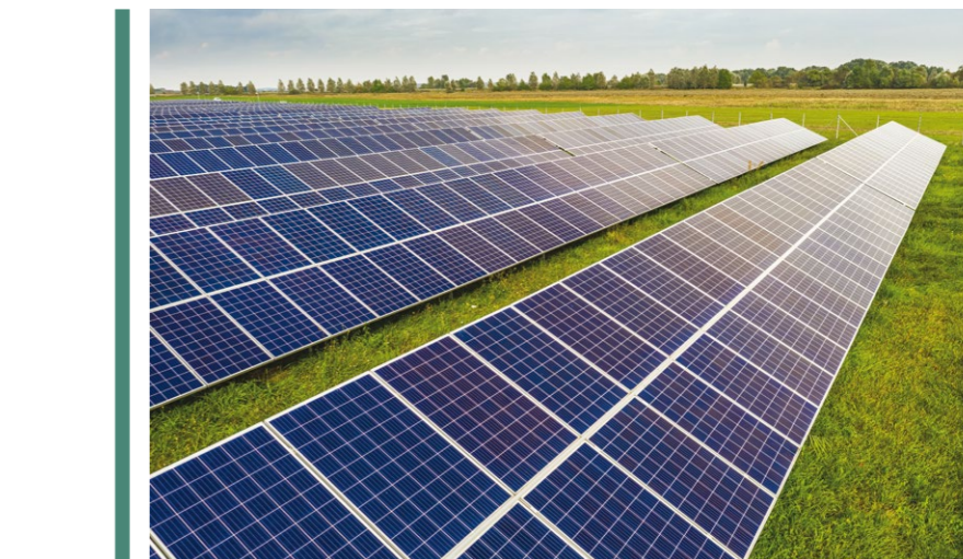
» E.ON által telepített napelemes rendszer Polgáron
